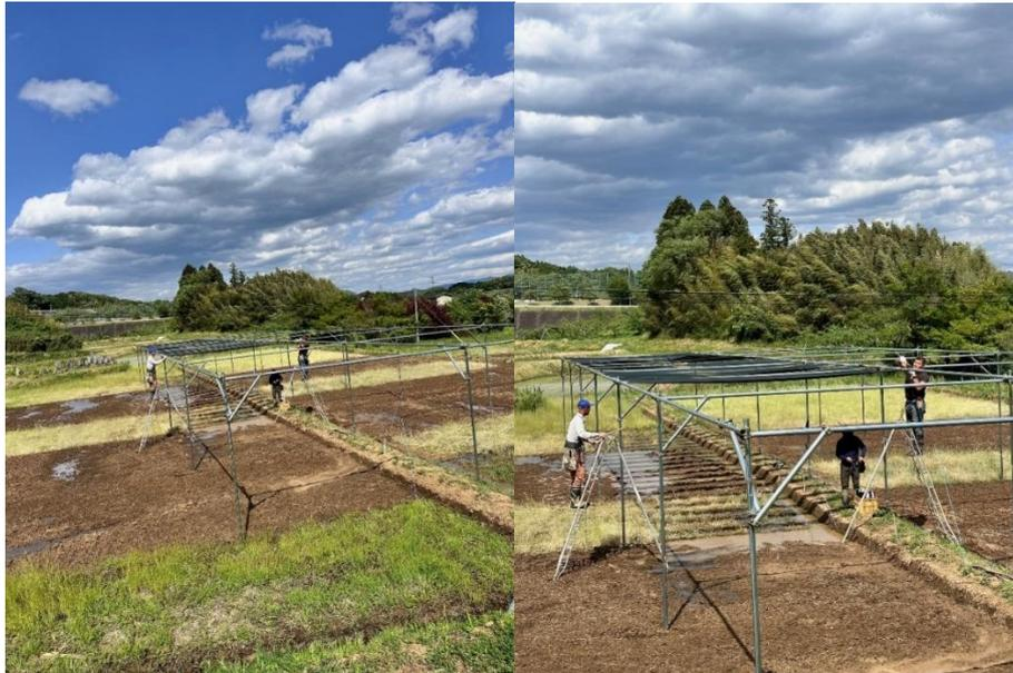
図 15 【テストプラント設置の様子③ダミーパネルを貼る：2024 年 4 月】
